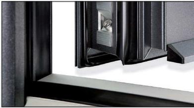
Stabile Eckverbindungen; Profile auf Gehung verschraubt, verklebt und verbolzt
